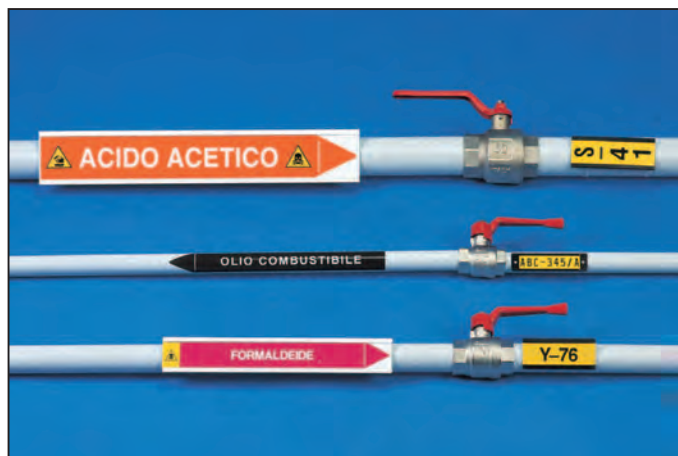
tubazioni con sistema TLS
