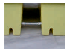
Particolare del raccordo
