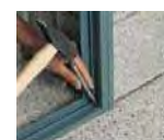
Distanziale inferiore asportabile manualmente.
